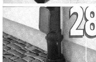
In cazul in care se opteaza pentru conectarea burlanelor direct la reteaua de canalizare, aceasta se poate face fie direct, insa in acest caz se recomanda folosirea unei piese de curatire (28), fie folosind sifonul special de burlan (29), care are din constructie si un element de decantare pentru frunze precum si o clapeta antirefulare.
