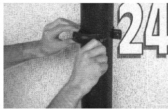
Distanța intre colierele de fixare pentru burlane nu trebuie să fie mai mare de 2 metri, indiferent daca acestea sunt din material plastic sau metalice.
