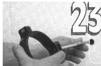
Fixarea burlanelor se face cu ajutorul colierelor de burlan din material plastic si a diblurilor cu holtsurub.
